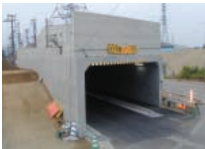
福岡209号津福本町地区改築工事 斜角度62°
