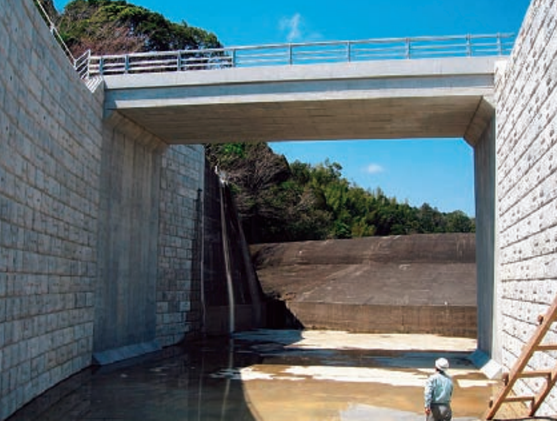
スパンザウォール工法
