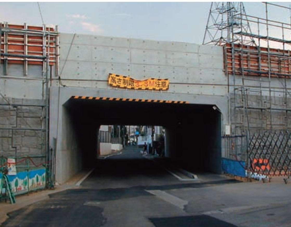
大型斜角カルバート
