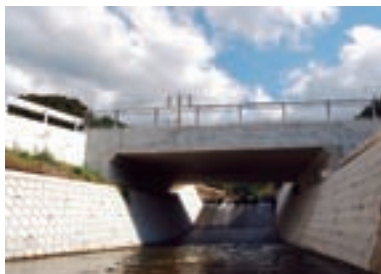
アセットマネジメント (大型ボックス) 佐賀県道山崎町切線
