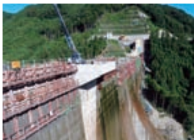
ダム関連製品 大分県大山ダム
